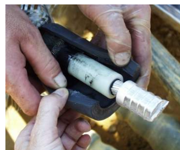
Figura 2: DP superficiales en el interior de un empalme
